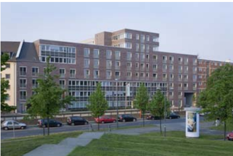
Abb. 2: Termingerecht stellte BAM Deutschland den Neubau des Bürokomplexes fertig. Foto: BAM Deutschland AG / AVP
