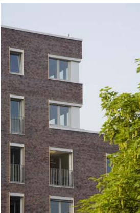
Abb. 3: Ein interessanter städtebaulicher Entwurf, eingepasst in die umliegende Bebauung Foto: Bam Deutschland AG / Godehardt
