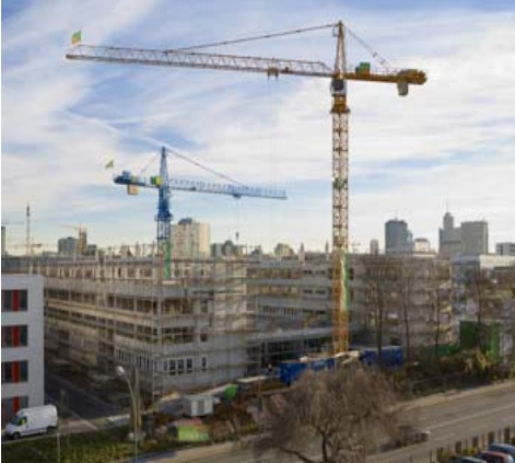
Abb. 1: In kurzer Bauzeit realisiert BAM Deutschland in der Essener Weststadt einen vielseitigen VARIOFFICE®-Neubau. Foto: BAM Deutschland AG /Godehardt
